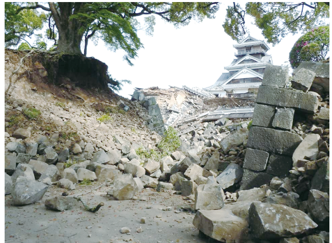
熊本城の被災状況(熊本市提供)
